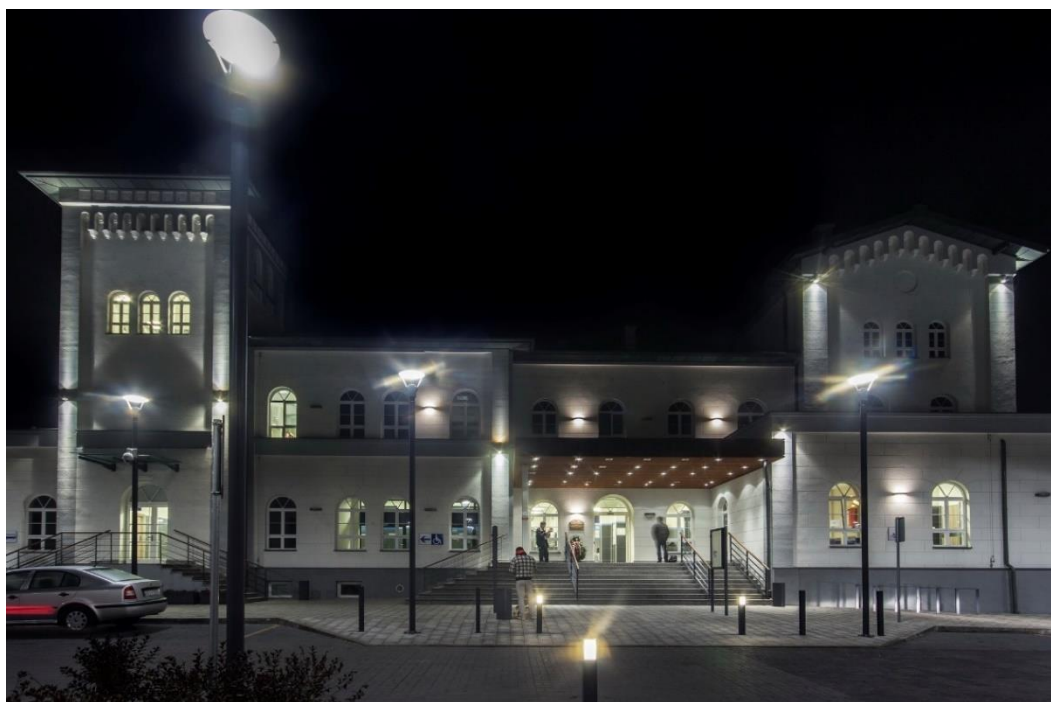
Dworzec kolejowy – źródło: https://zielonaos.kutno.pl/zabytek/15
