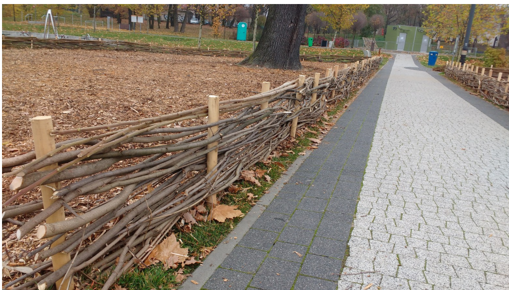
Przykład niskiego faszynowego płotka
