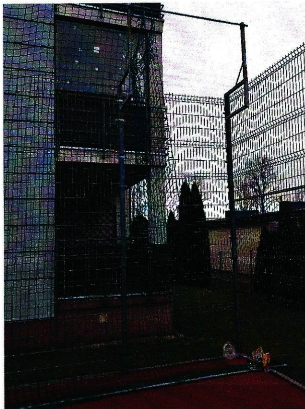
Fot. 2. Widok siatki zabezpieczającej od strony szczytowej ściany bloku mieszkalnego oznaczonego nr 10
