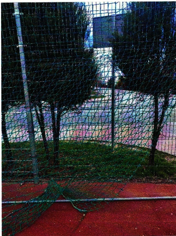
Fot. 1. Widok siatki zabezpieczającej od strony ul. Szymanowskiego
