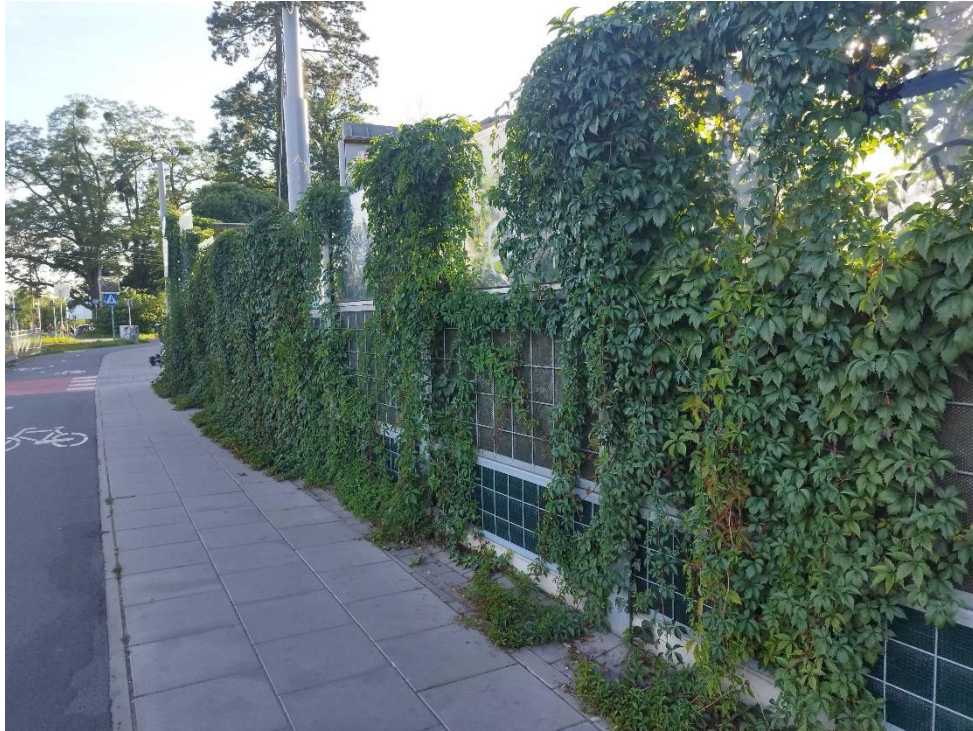
Fot. 1 Wykorzystanie pnączy na ekranach akustycznych Wrocław-ul. Karkonoska (fot. M.Stobińska)
